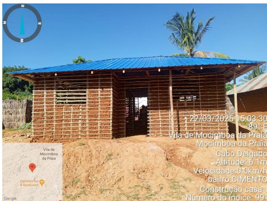
Figura 4: Processo construtivo com a técnica da taipa de mão
