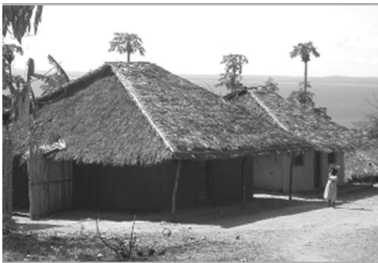
Figura 1: Casa do tipo swahili com telhado de quatro águas
